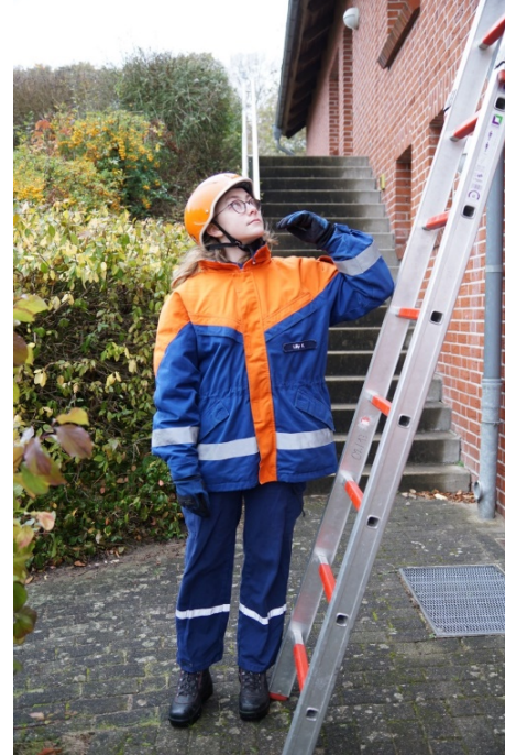
Hier ist die Prüfung des richtigen Anstellwinkels von 65° - 75° zu sehen.
